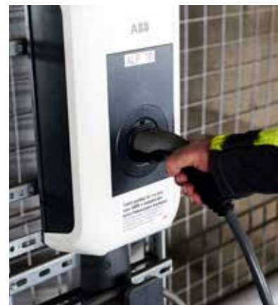
Latauspistokkeen tyyppi kannattaa valita harkiten. Tyypejä on neljä, joista yleisimpiä ovat Tyyppi 1 (japanilaiset ja yhdysvaltalaiset autot) ja Tyyppi 2 (eurooppalaiset autot).
