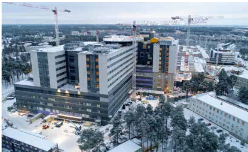
Oulun yliopistollisen keskussairaalan uuden sairaalarakennuksen on määrä valmistua vuonna 2030, jolloin se on visionsa mukaan maailman älykkäin sairaala.
