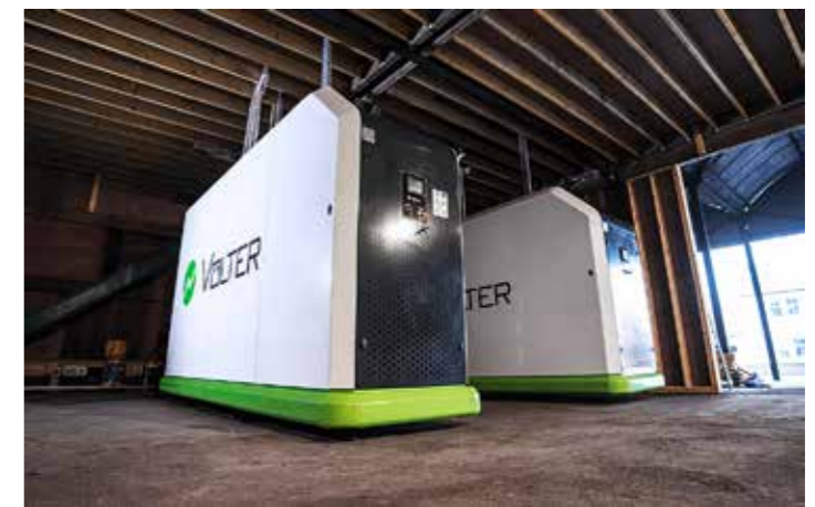
Volterin siirrettäviä biomassavoimaloita valvotaan etänä.
