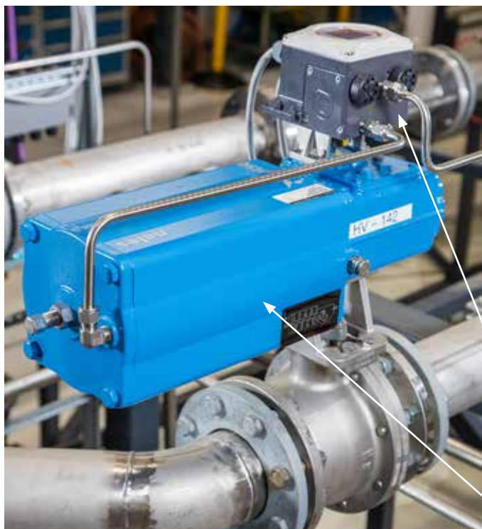
Asennoittimen tehtävänä on säätää putkessa olevan venttiilin avaus ohjaamalla paineilmaa toimilaitteeseen ja sieltä ulos.
