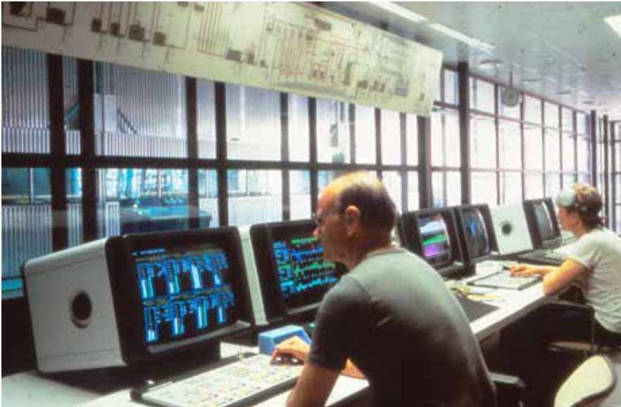
Valmetin Damatic-järjestelmällä toteutettu valvomo 1970-luvulta.
