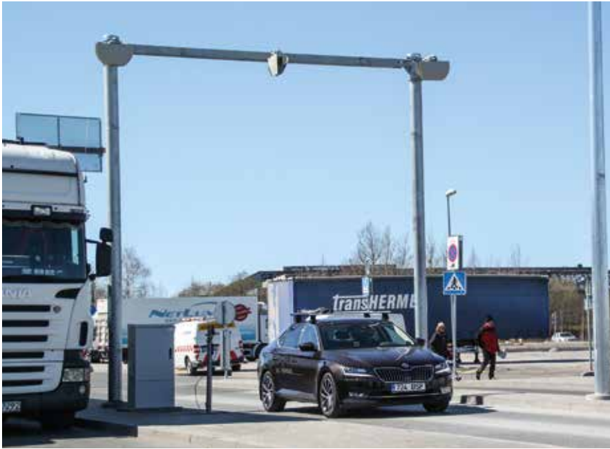
FPS503-järjestelmässä on kolme LMS511 LiDARia, joilla saadaan mitattua ajoneuvon äärimitat. Kaksi sivulla olevaa LiDARia mittaa ohikulkevan ajoneuvon leveyden ja keskellä pitkittäin oleva LiDAR mittaa ajoneuvon pituuden.
