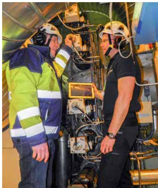
Tom Bäckman ja Antti Roponen tutkimassa turbiinille asennettuja uusia asentoantureita.
