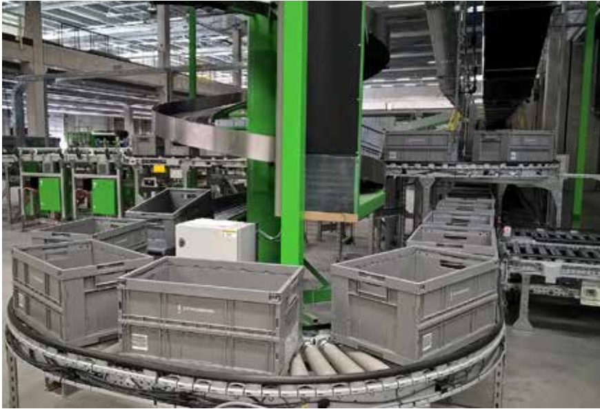
Stockmannin uudessa automaattivarastossa tavarat liikkuvat kuljettimilla 100 000 standardikokoisessa laatikossa. Kuva järjestelmän testausvaiheesta.
