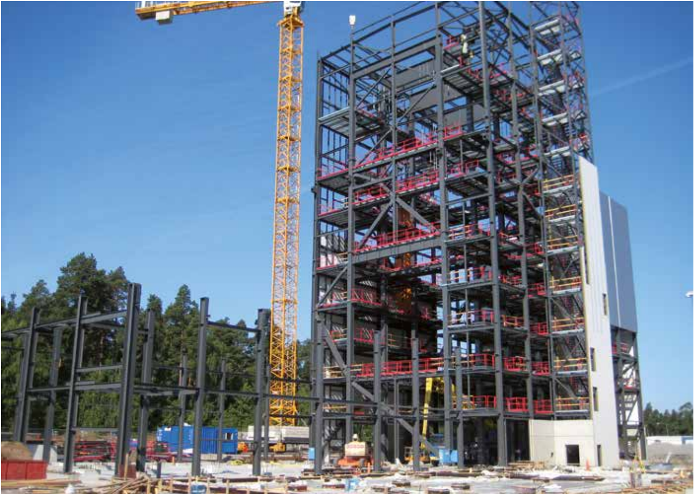
Kavamet Oy / EON:n Biojätevoimalaitoksen teräsraakenteet 1500tn, Norrköping Ruotsi.
