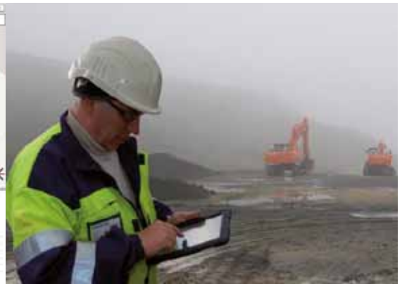
Kuura Tablet -järjestelmä tienrakennustyömaalla. Kuvassa työnjohtaja tarkastelee koneohjausmallin yhden kohdan poikkileikkausta.
