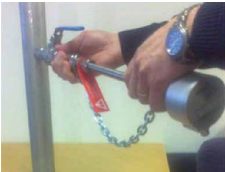
Kun anturin pää on asennettu kanavan keskelle, voidaan kiristysliitin ja ketju säätää lopulliseen kireyteensä.
